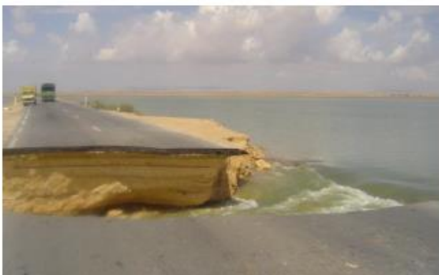
Figures 3 et 4. Vue des dégradations de la route en période d'inondation
