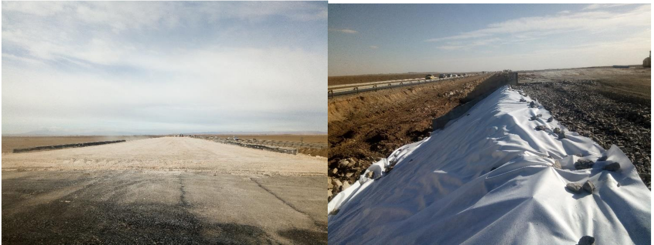
Figures 13 et 14. Montée du remblai et mise en œuvre du géotextile sous enrochement
