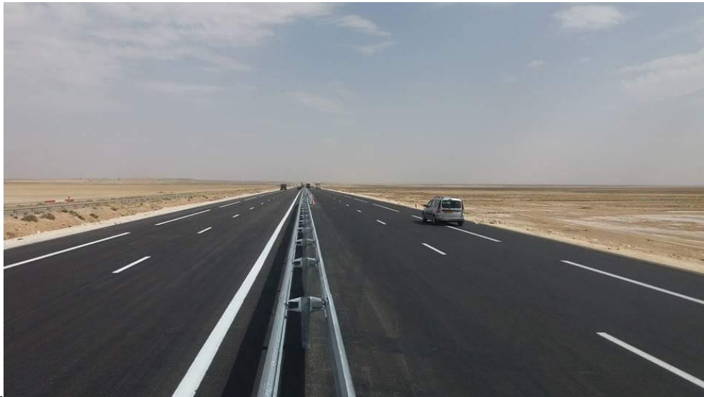
Figure 15. L'infrastructure achevée au niveau de la zone de la sebka
