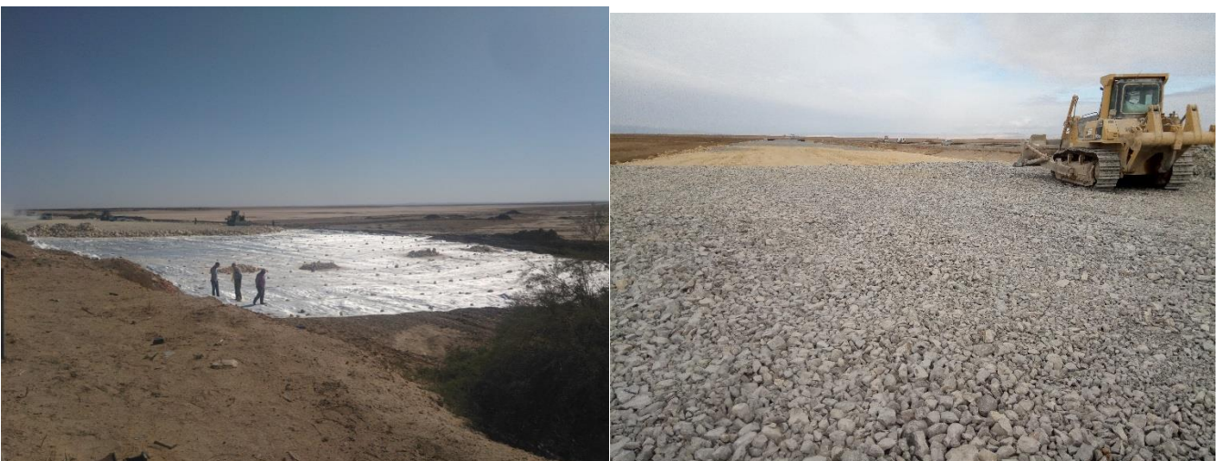
Figures 11 et 12. Mise en œuvre du géotextile de renforcement et des matériaux ZI
